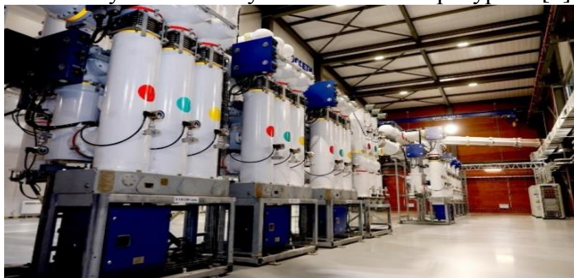
Рисунок 2 – Помещение КРУЭ-110 кВ на ПС «Спутник».
