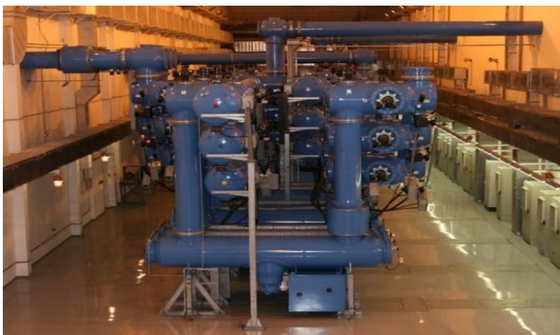
Рисунок 1 – зал КРУЭ-500 кВ на подстанции «Западная»
