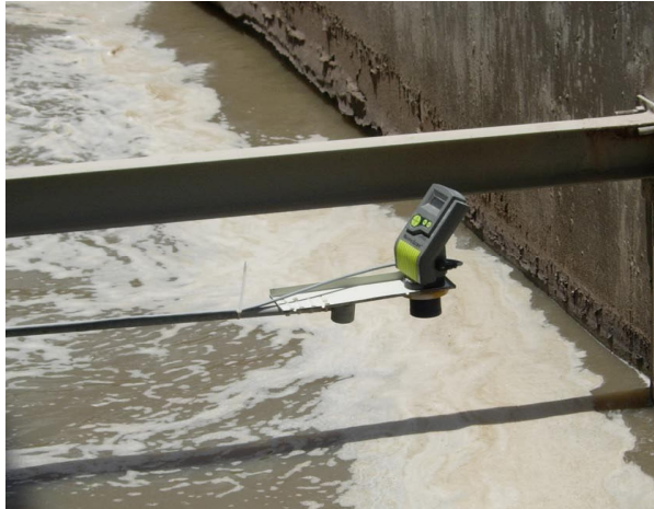
Рисунок 3 – Ультразвуковой датчик уровня
