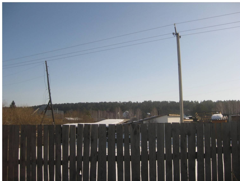
Рисунок 3 – Расположение опоры линии электропередач на земельном участке
